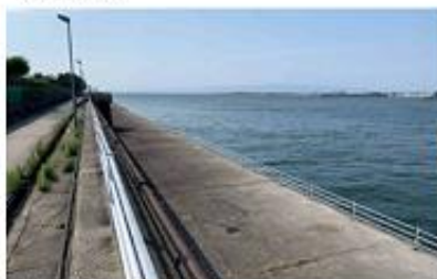
平時は閉鎖している護岸施設
