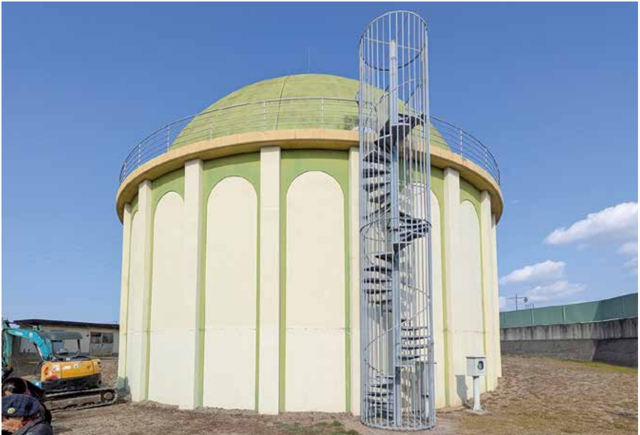
写真：北出配水場
