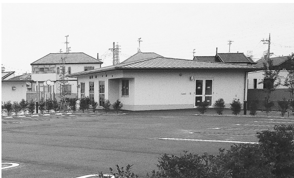
◀完成した地域子育て支援センター「ひだまり」の全景
