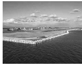
▲消波ブロック設置
