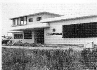
▲工事の進む福祉センター
