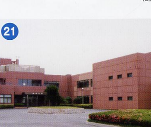
● 南大阪湾岸流域下水道北部水みらいセンター 〒595-0814 新浜3 TEL:072-423-2255
