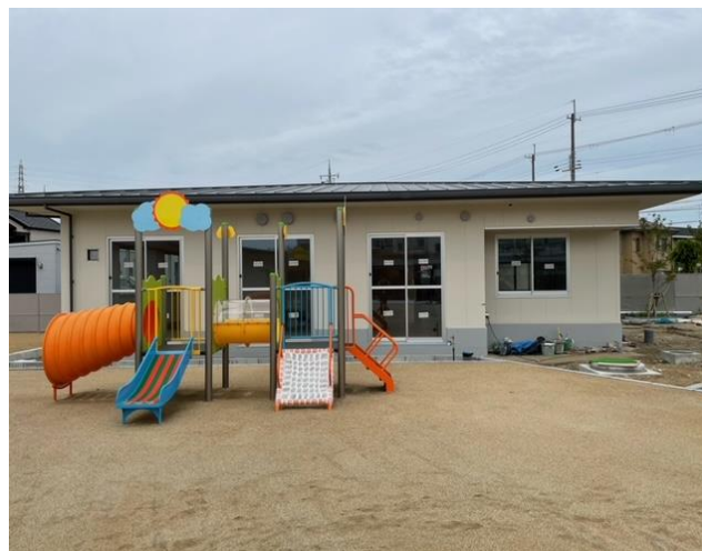
子育て支援センター（広場側から）
