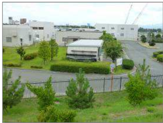
【南大阪湾岸流域下水道北部水みらいセンター】
