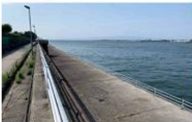
平時は閉鎖している護岸施設
